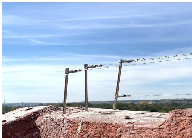
El **sistema de postes y alambres** es un sistema barrera que evita que las aves puedan acceder y posarse a ciertas zonas. Con esta instalación evitamos que en el aterrizaje de las aves y su consiguiente “trepada” se posen en los lugares donde se instala este mecanismo. Es un sistema **discreto que evita la visualización del problema de aves** en una zona determinada.
